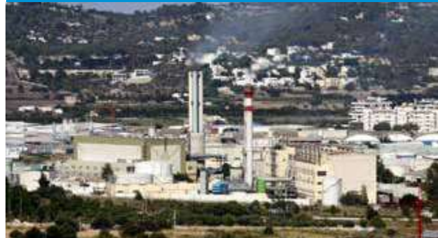
Central térmica GESA
