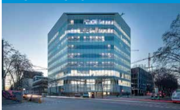
Hexagon Building 22@ Oficinas
