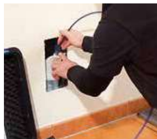
Limpieza de conductos
